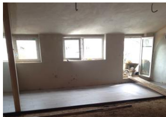
El local del Centro en construcción
